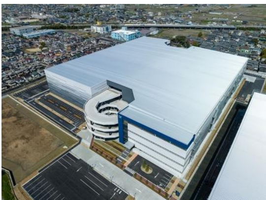
【LF 奈良外観】奈良県では初となるマルチテナント型の物流施設。45 フィートコンテナ車が直接各階に接車可能
