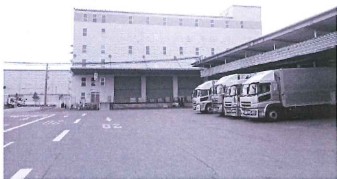
東大阪トラックT内に確保した東大阪倉庫
