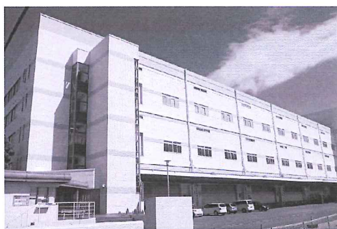
「第1流通センター」の「汐見」倉庫の大阪泉大津にある
