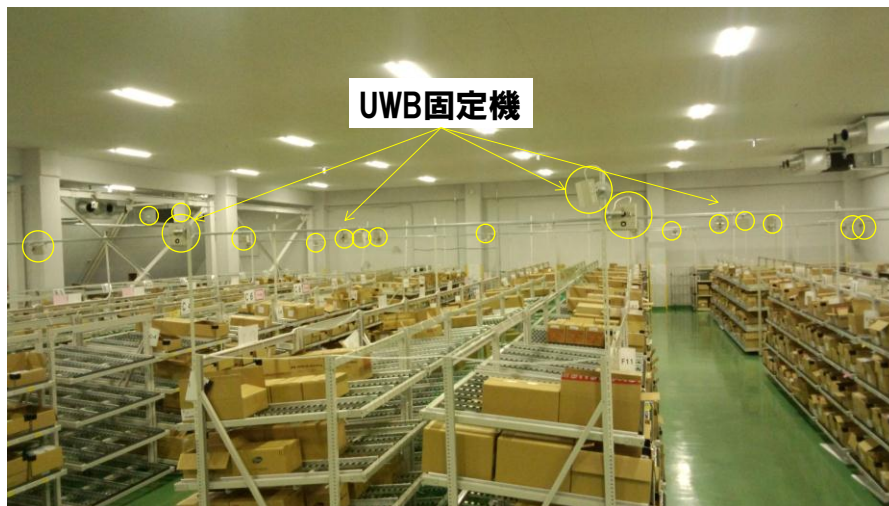
図4 物流倉庫に設置した固定機
